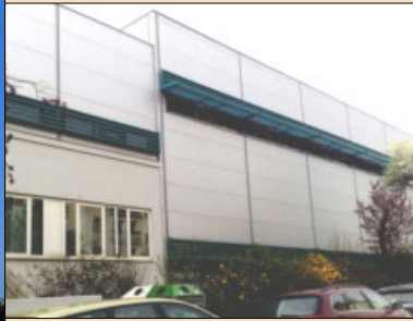
Goethe Gymnasium Turnhalle
